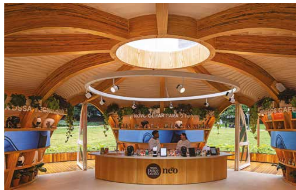
O espaço tem estrutura pré-fabricada em madeira de reflorestamento
