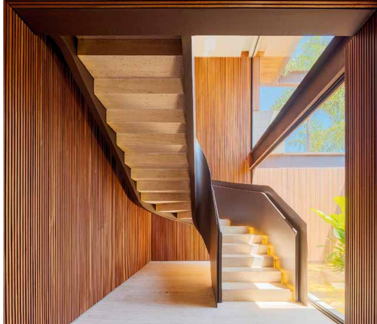
A escada projetada em metal Corten, com degraus em mármore travertino
