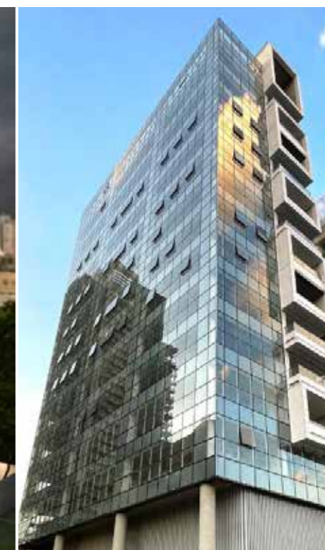
Edifício Rubens Parada - Av. Rebouças, 2748 - SP
