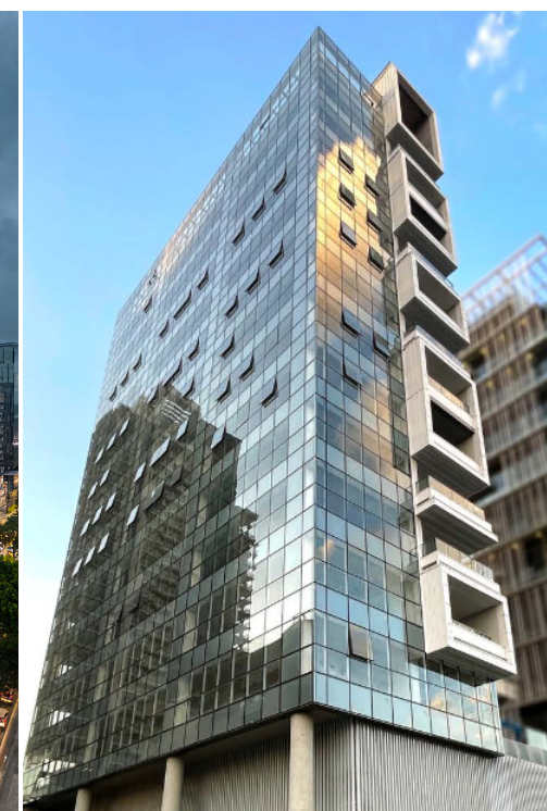
Edifício Rubens Parada - Av. Rebouças, 2748 - SP
